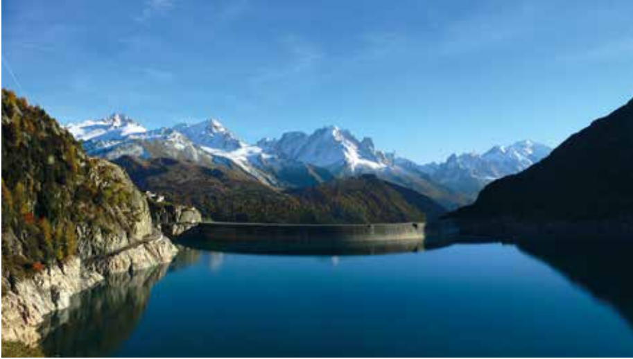
Photo 1 – Émosson des six Jeurs (© Électricité d'Émosson SA)
