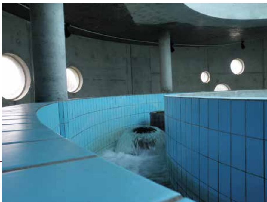
Photo 1 – Arrivée de l'eau brute dans la couronne de départ du traitement de l'Unité de Production d'Eau potable de Mémard à Aix-les-Bains (© Services techniques d'Aix-les-Bains)
