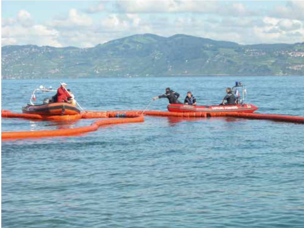
Photo 2 – Pose de barrages flottants sur le Léman (© CIPEL)
